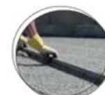
Betoniilha com isolamento térmico
