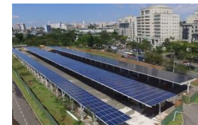
Exemplo da substituição de uma instalação fotovoltaica em parque de estacionamento
